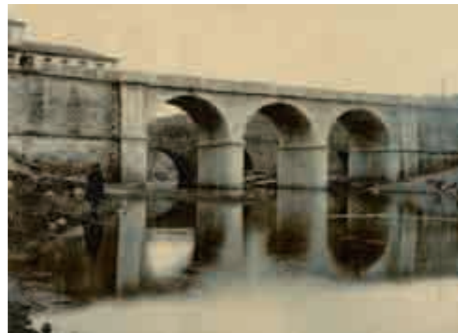
Puente Nuevo. J. David, 1884.
